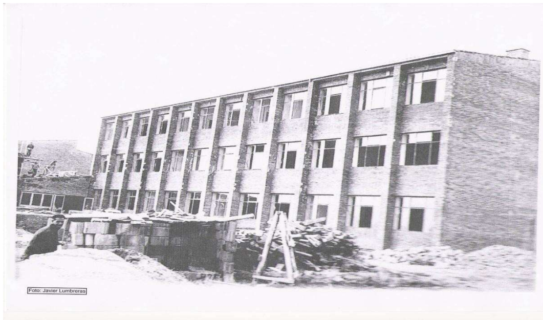
Imagen de la construcción del edificio original hacia 1969 (Foto Lumberas)
